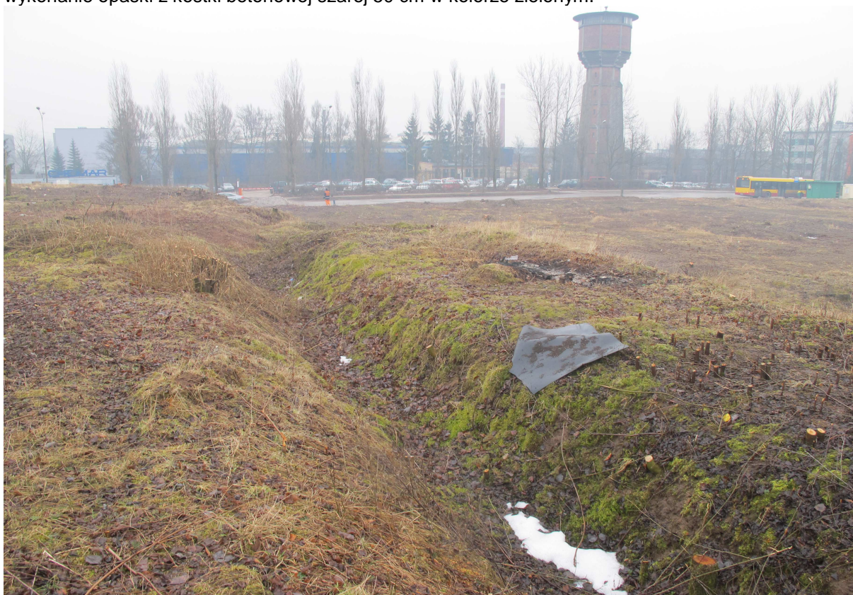
Widok rowu w skarpie istniejącej. Rów do wypełnienia gruntem rodzimym pozostałym po niwelacji terenu.
