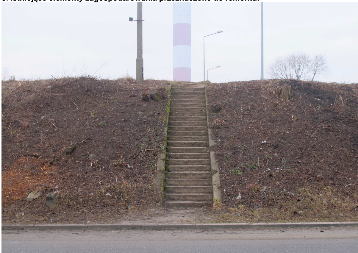
Schody terenowe do remontu poprzez: Ułożenie opaski z kostki zielonej wzdłuż krawędzi schodów szerokości 30 cm. Płaszczyzna 5cm poniżej policzków schodów, wykonanie spocznika dolnego z kostki betonowej zielonej do krawężnika istniejącego.
