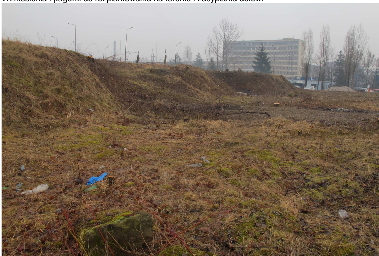
Profil skarpy do uzupełnienia gruntem rodzimym poprzez przemieszczenie mas ziemnych. Projektowany spadek skarpy ok.18,8 st. Średnia szerokość skarpy 5,3m.
