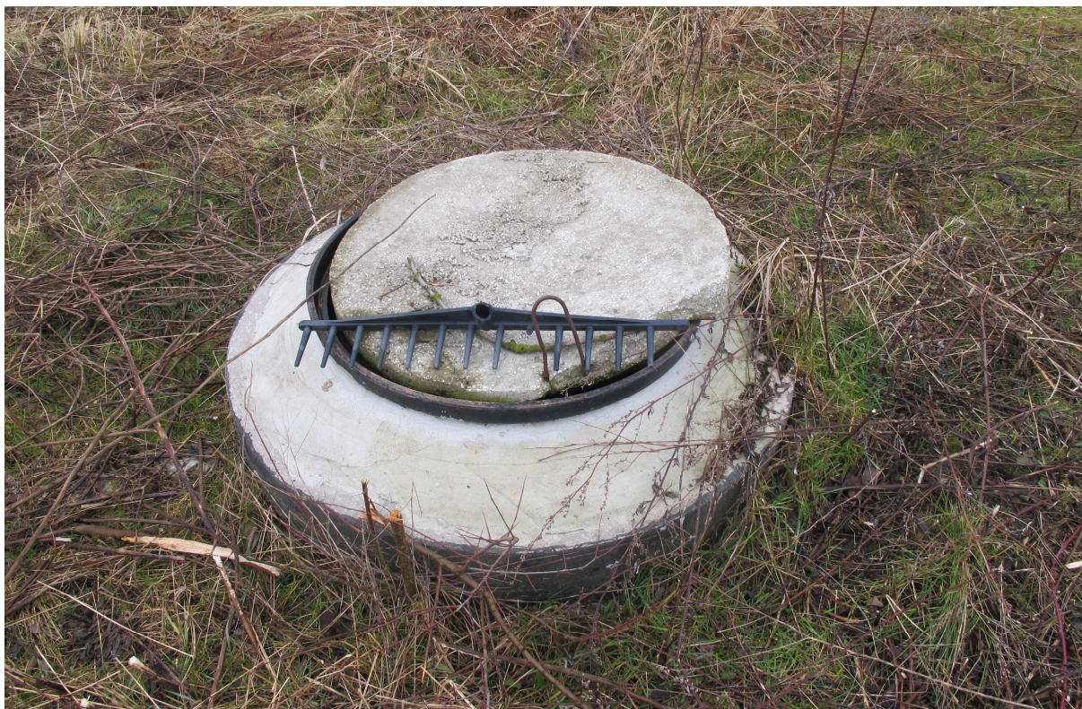
Istniejąca studnia do remontu poprzez: wymianę pokrywy na żeliwną, gruntowanie, uszczelnienie i wykonanie opaski z kostki betonowej szarej 50 cm w kolorze zielonym.
